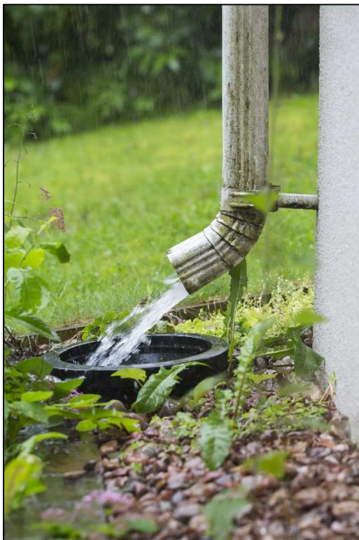
Figuur 225: Afkoppelen dakafvoer van het afvoerstelsel.
