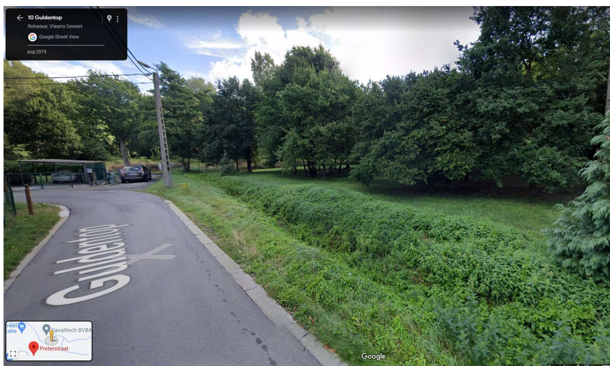
Figuur 193: Gracht vanuit het noordoosten stroomt richting Guldentop 3 waarin meer buffering voorzien kan worden (bron Google Street View)
