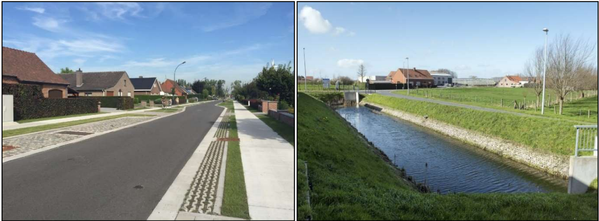
Figuur 226: Links: Lokale infiltratie wegverharding en fietspad. Rechts: Infiltratiebekken.
