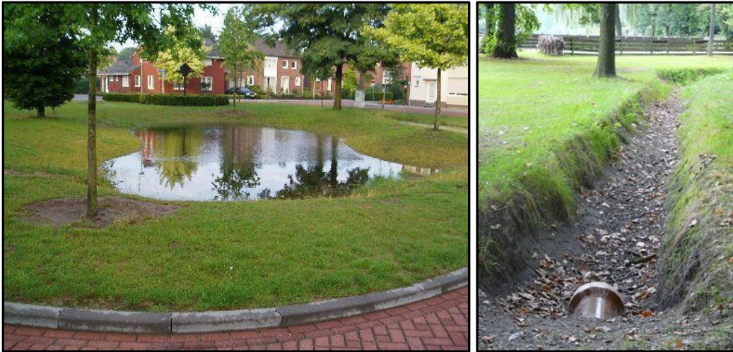
Figuur 78: Voorbeeld wadi en infiltratiegracht (Waterbewust bouwen, 2020)
