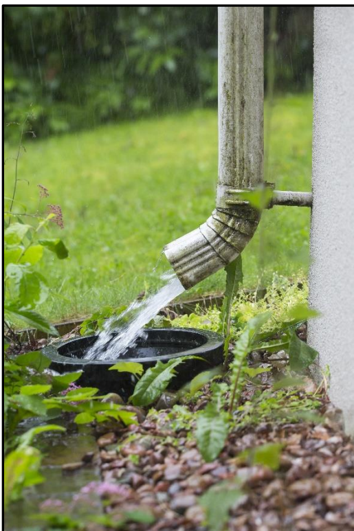
Figuur 75: Afkoppelen dakaafvoer van het afvoerstelsel
