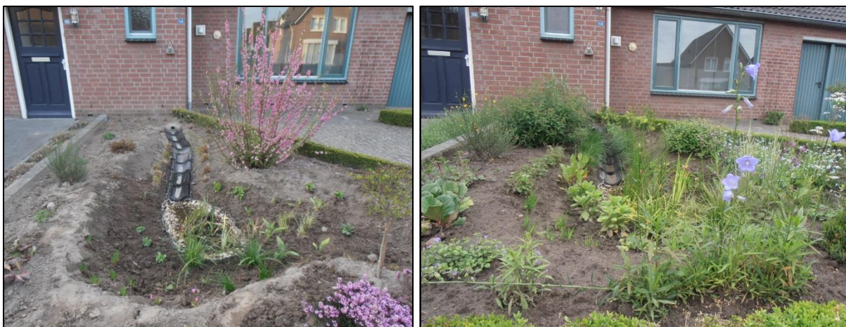
Figuur 73: Regenwater naar wadi in voortuin (links: aanleg wadi, rechts: wadi voltooid) (Van Assche, 2020)
