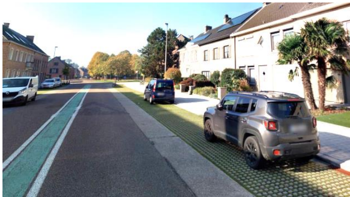
Figuur 92: Waterdoorlatende parkeerstrook Eupenlaan, Temse
