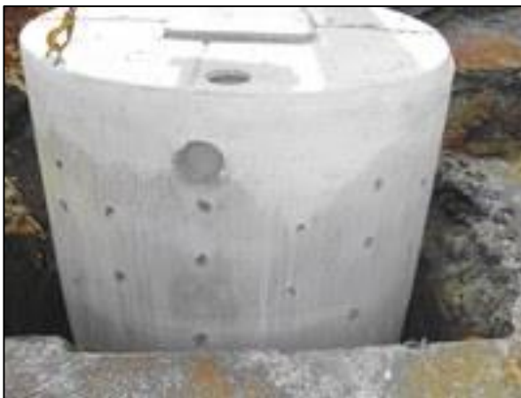
Figuur 95: Infiltratieput (VMM, Infiltratie, 2020)
