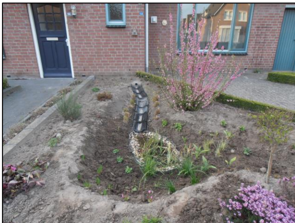
Figuur 74: Regenwater naar wadi in voortuin (links: aanleg wadi, rechts: aanplant wadi) (van Eck, 2016)
