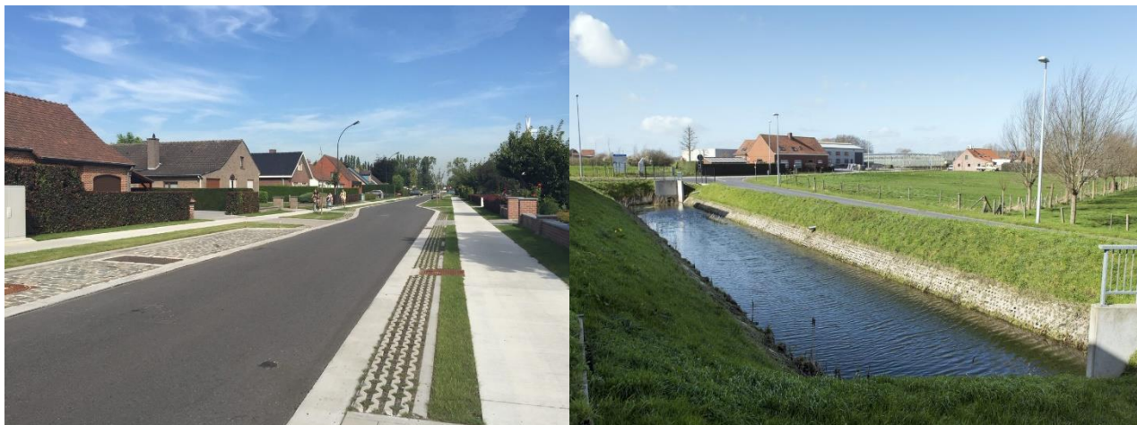
Figuur 64: Links: Lokale infiltratie wegverharding en fietspad. Rechts: Infiltratiebekken
