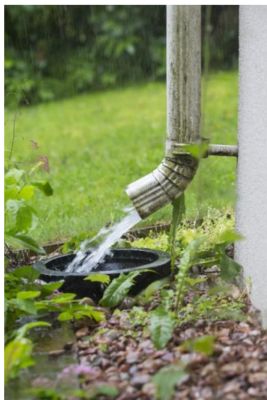
Figuur 52: Afkoppelen dakafvoer van het afvoerstelsel
